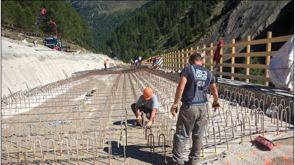
Bild 9: Schubverdübelung
