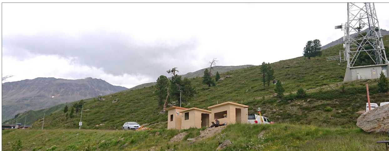
Abbildung 4: Die Messhütten nahe der Mautstation Timmelsjoch.
