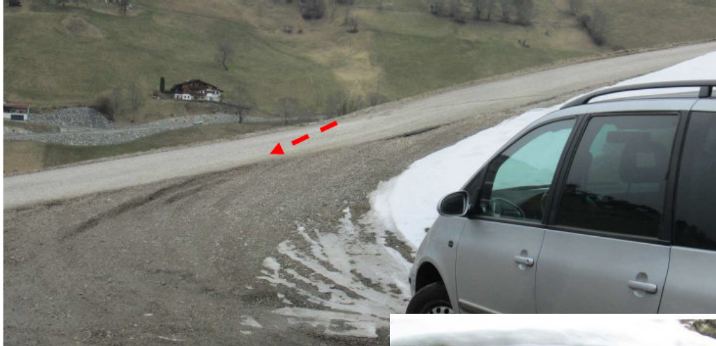
Bild 28: Setzungsmulde im Asphalt vor dem Haus
