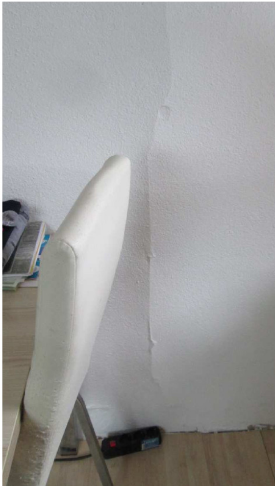
Bild 8 und 9: Aufkantung/Knick in der Wand- und Deckenverkleidung
