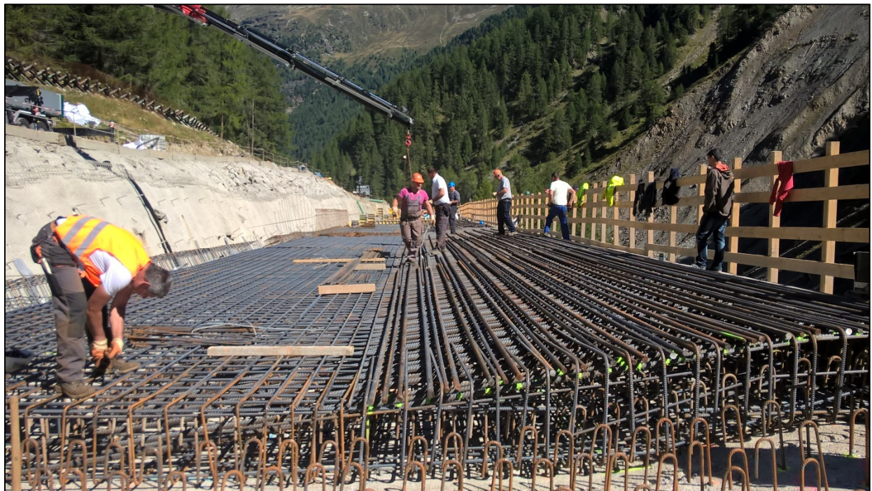
Bild 10: Bewehrung Aufbetonplatte
