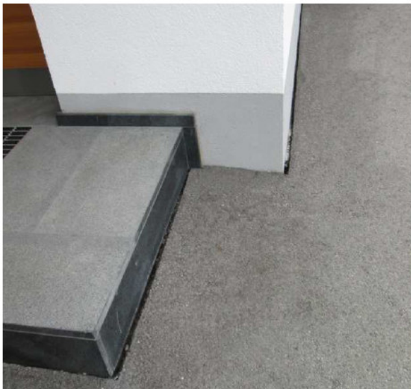
Bild 10 und 11: Asphaltablösungen und Setzungen entlang der Fassade
