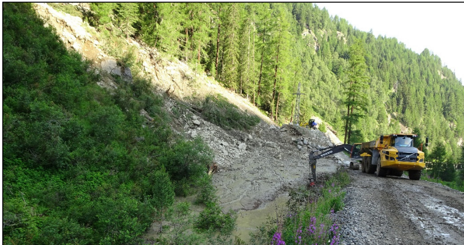
Abb.15. Beräumung des Lawinauffangbeckens
