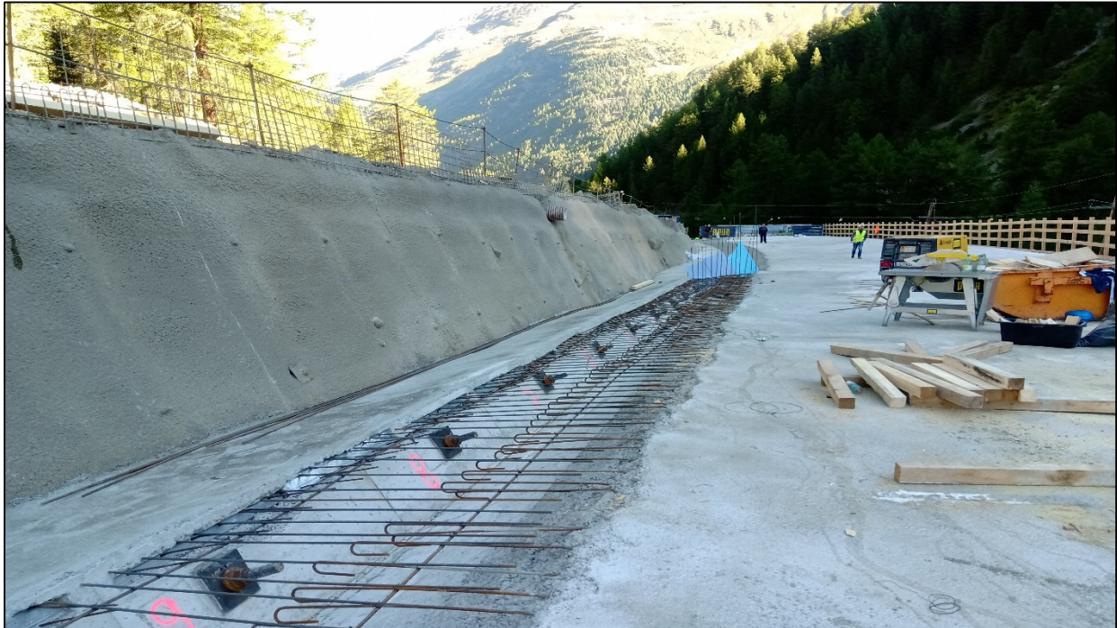
Bild 11: Spritzbetonnagelwand, Spannischen - Verpressanker
